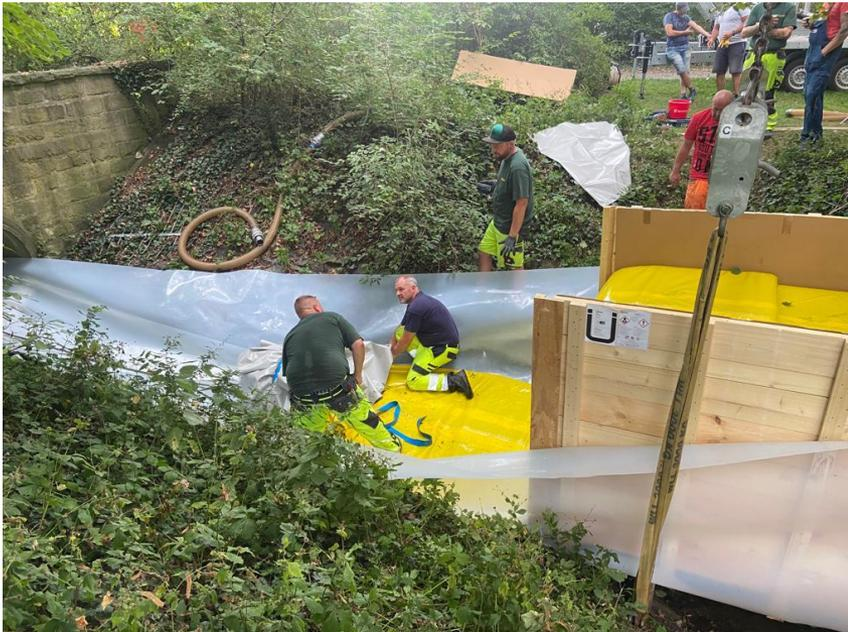
Mit Druckluft aufgestellter Liner (DN 1500) im Bereich Pflanzgarten. Größter Liner der bisher in Helmstedt eingebaut wurde
