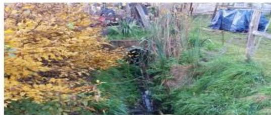
Der Graben ist sehr zugewachsen, das Gewässerprofil ist aber frei und die hydraulische Funktion des Grabens ist augenscheinlich noch nicht beeinträchtigt. Der ins Abflussprofil ragende Gehölzbewuchs sollte zurückgeschnitten werden. Unterhaltungspflichtig ist die FI Barmke.
