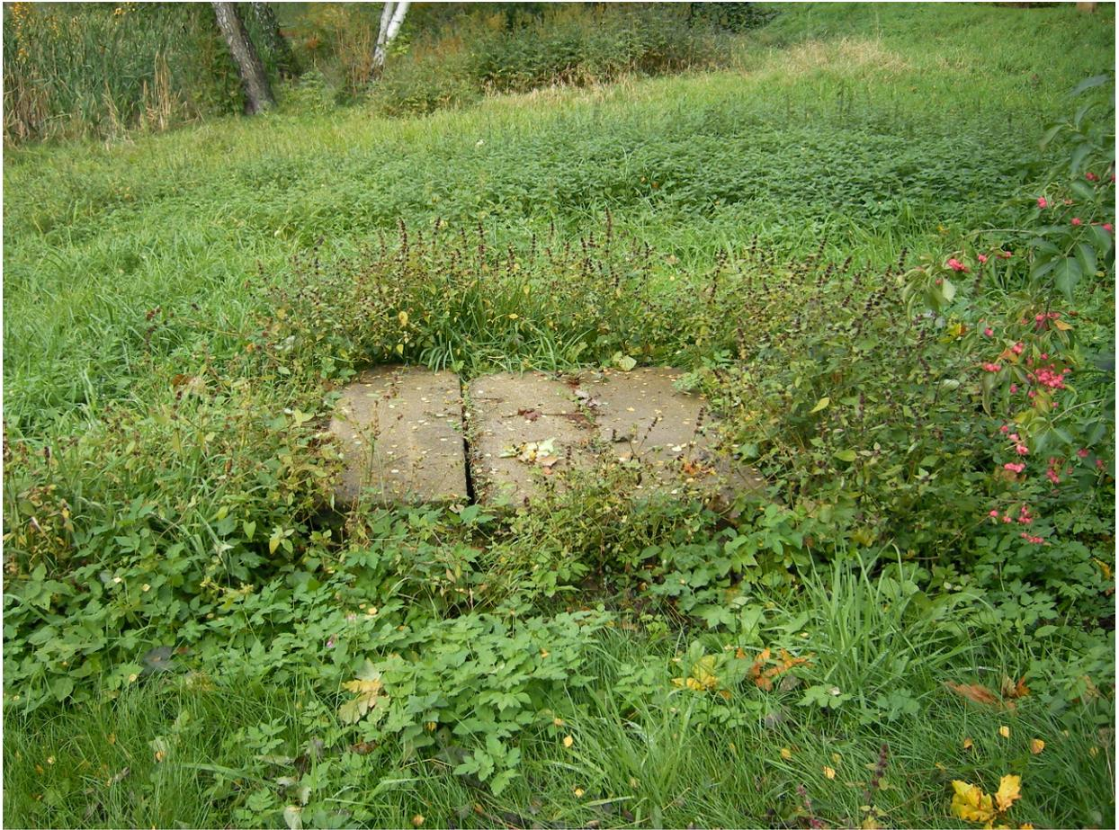
Diese sind aus Ziegelsteinen rund gemauert. Im Schritt 4 soll auch die **Abdeckung dieser beiden Schächte** erneuert werden, welche momentan aus angebrochenen Betonelementen bestehen, soweit noch ausreichende Mittel bereitstehen. Hierzu ist es beabsichtigt, die Betonelemente gegen eine Stahlplatte auszutauschen, welche in der Mitte einen Ausschnitt mit Glasplatte besitzt.
