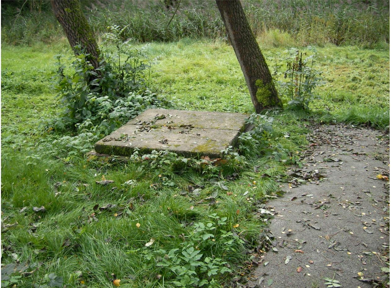
Für die (seltene, aber doch ab und zu notwendige) Wartung des Ablaufes und des Schachtes ist eine Zugangsmöglichkeit des Schachtes vorzuhalten, was eine schwere Glasabdeckung verhindern würde. Auch aus diesem und den anderen vorgenannten Gründen wären die beiden oben diskutierten Lösungsvarianten der Abdeckung als mittlerweile überholt anzusehen.
