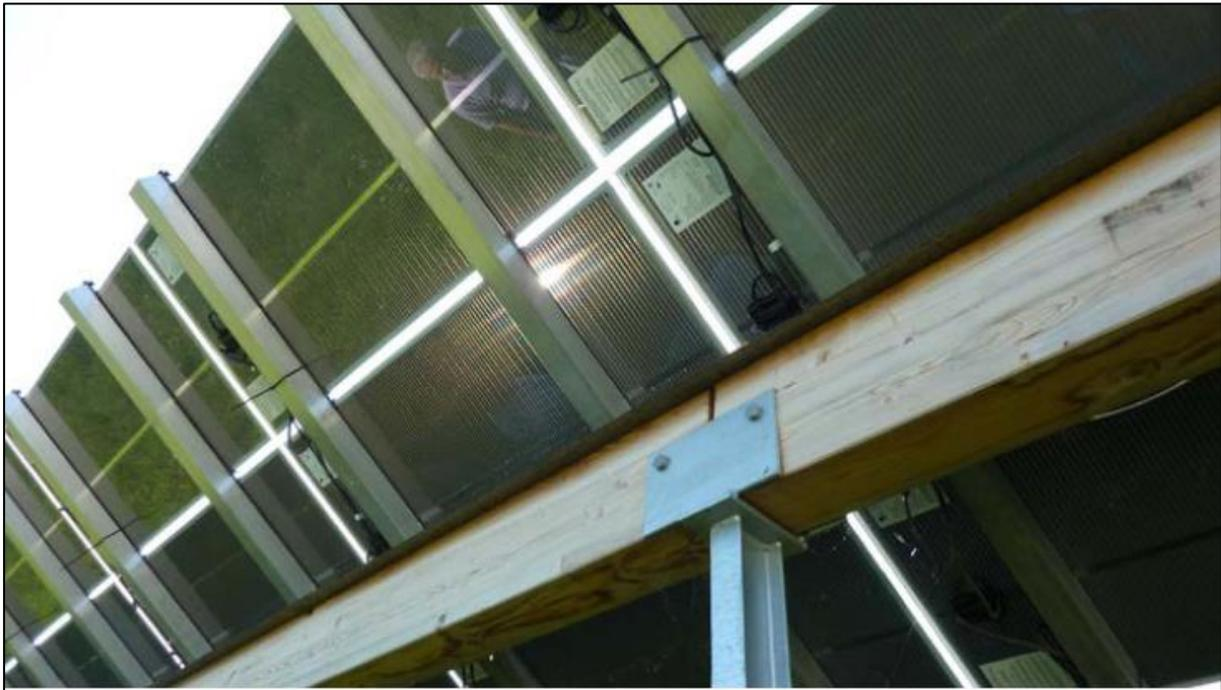
**Abb. 11: Wasserablauf zwischen den Modulen durch Abstände (übernommen aus (LFU 2014))**
