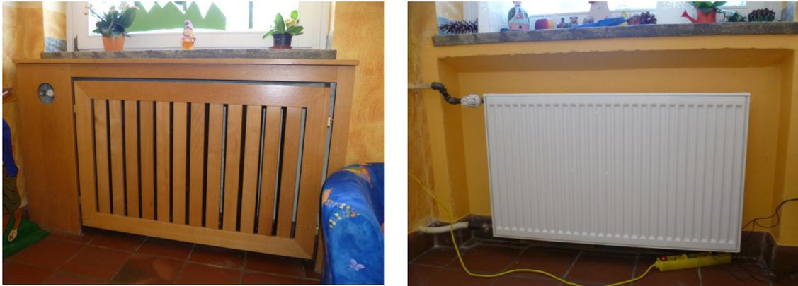
Abbildung 15: alter Heizkörper im Kindergarten Barmke mit Verkleidung und neuer Heizkörper ohne
