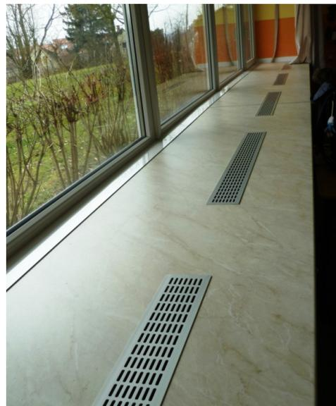
Abbildung 16: GS Lessingstraße: Alte Steinfensterbank und neue GetaLit-Fensterbank mit Lüftungsschlitzen
