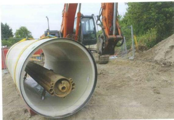
Mit Förderschnecken, die in gesonderten Inliner-Rohren geführt werden, wird das abgebaute Bodenmaterial durch den Rohrstrang in die Startbaugrube transportiert. | Foto: Amiblu GmbH
