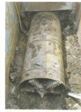
Ankunft der unbemannten arbeitenden Vortriebsmaschine in der Zielbaugrube | Foto: Abwasserentsorgung Helmstedt
