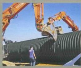
Das Titelbild zeigt einen Löschwasserbehälter aus Kunststoff mit einem Nutzvolumen von 100 m<sup>3</sup> in DN 2500 mm nach der DIN 14230. Die Anger Systemtechnik GmbH fertigt Rohr- und Schachtssysteme aus Kunststoff und ist spezialisiert auf Behälter, Stauraumkanäle sowie Sonderbauten nach individuellen Anforderungen des Kunden. Mehr Infos unter [www.anger-st.de](http://www.anger-st.de)
