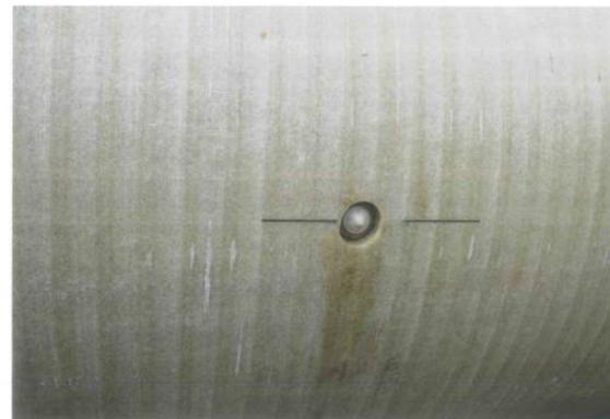
Stutzen für die Injektion der Bentonitsuspension in den Ringspalt | Foto: Amiblu GmbH
